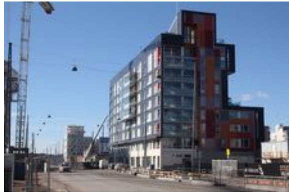
Figur 19 Casa Malta på Busholmen, Hem i Stans första byggemenskap. 61 lägenheter och gott om gemensamma lokaler. Arkitekt House Oy/ Pentti Kareoja & Heljä Herranen.
