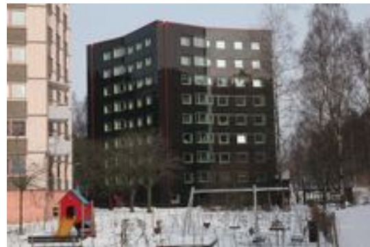
Figur 9 Hela fasaden i Kollektivhuset Stacken i Göteborg fick en beklädnad med solpaneler 2016 - 2018. En sorts bygggemenskap!
